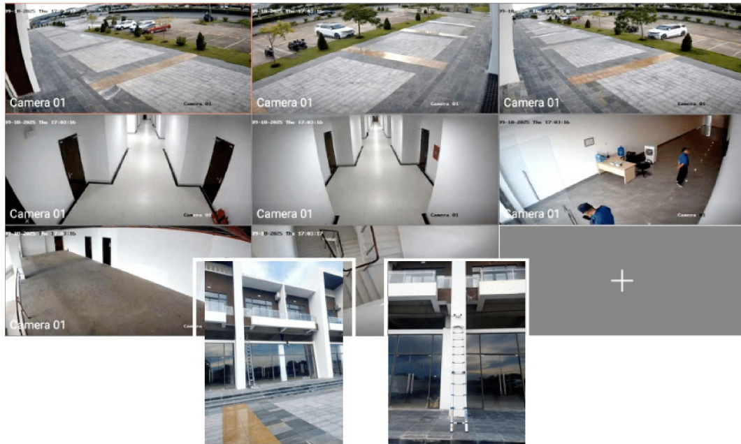
Lắp đặt hệ thống camera giám sát
