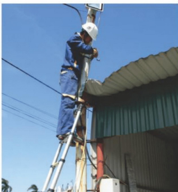
Lắp đặt hệ thống camera giám sát
