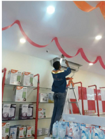
Lắp đặt hệ thống camera quan sát
