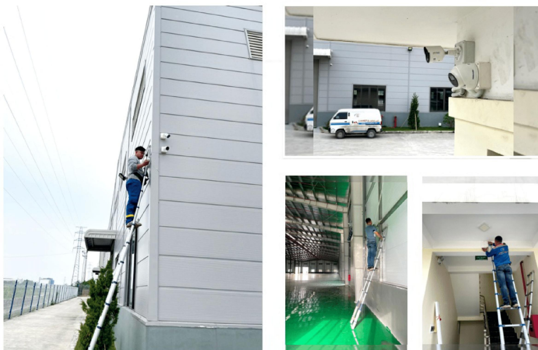
Hình ảnh thi công thực tế
