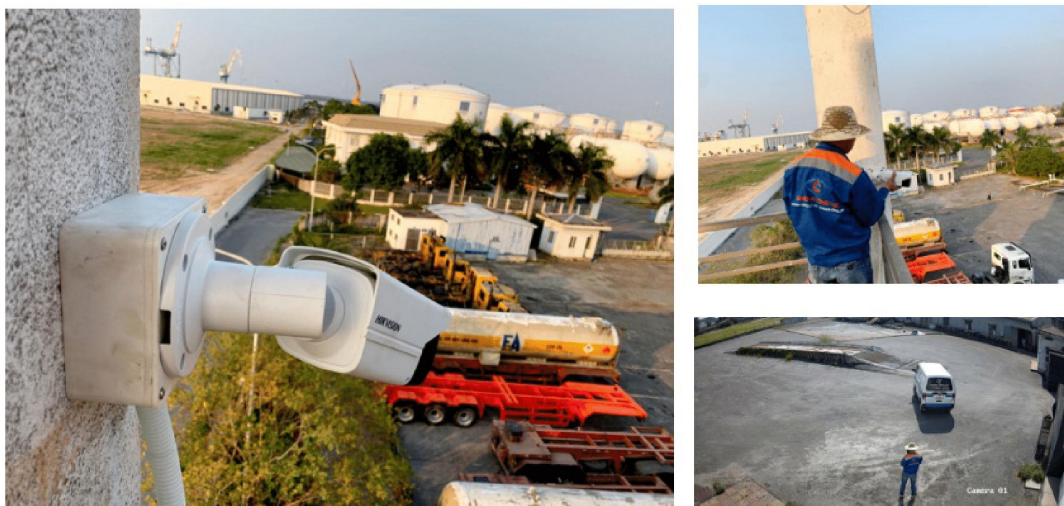
Lắp đặt hệ thống camera giám sát
