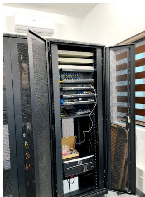
Hình ảnh thi công thực tế
