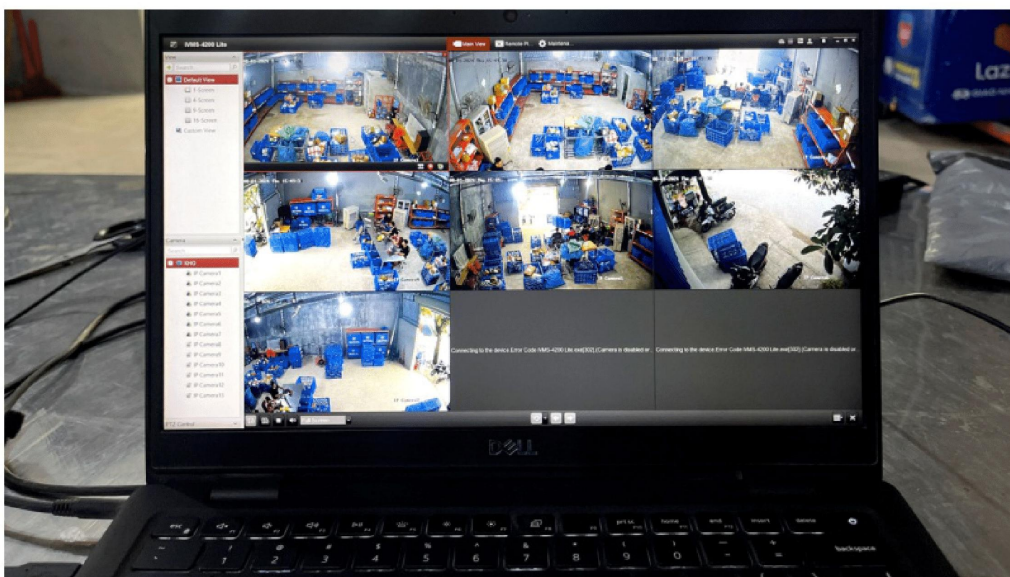
Lắp đặt hệ thống camera giám sát
