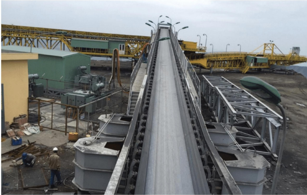
Lắp đặt hệ thống camera quan sát các trạm băng tải than 7km
